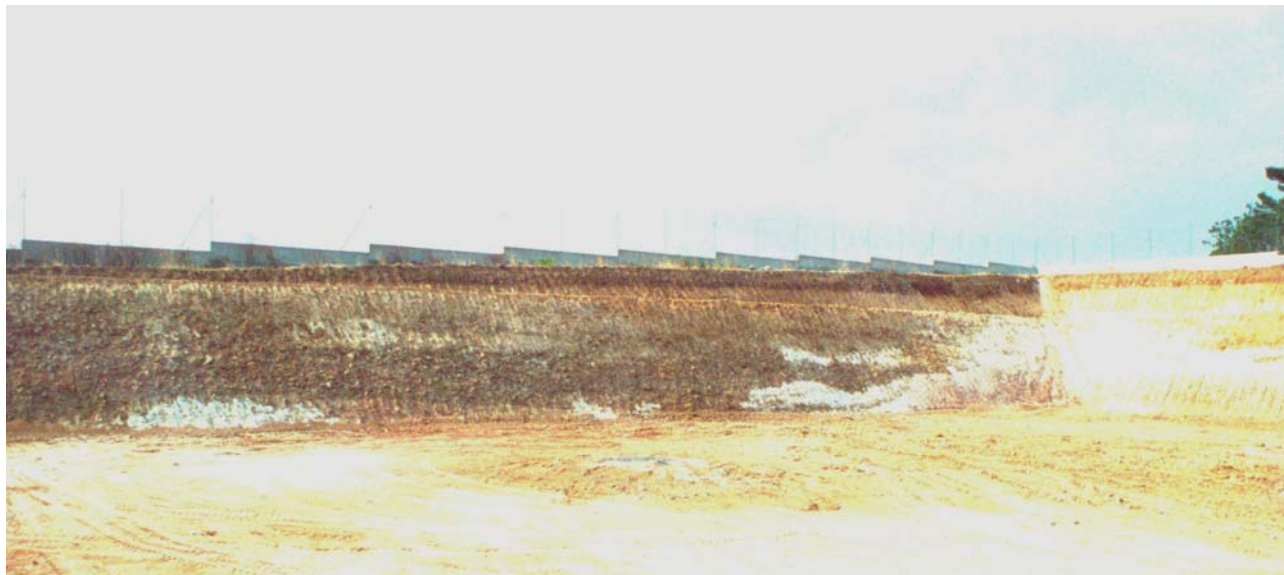
Foto – La scarpata nord della piazzola del Rifornitore AGIP sulla SS 131 durante la costruzione mostra i rapporti tra il Terziario e i depositi Quaternari
