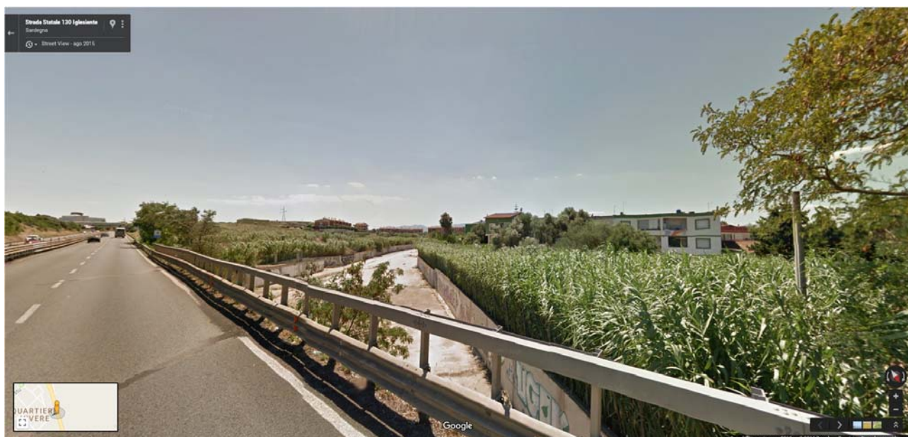
Foto - Il Rio di Sestu interamente rivestito e canalizzato a valle della SS 130
