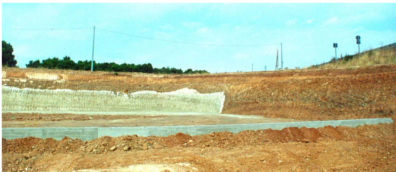
Foto – La scarpata est della piazzola del Rifornitore AGIP sulla SS 131 durante la costruzione mostra i rapporti tra il Terziario e i depositi Quaternari
