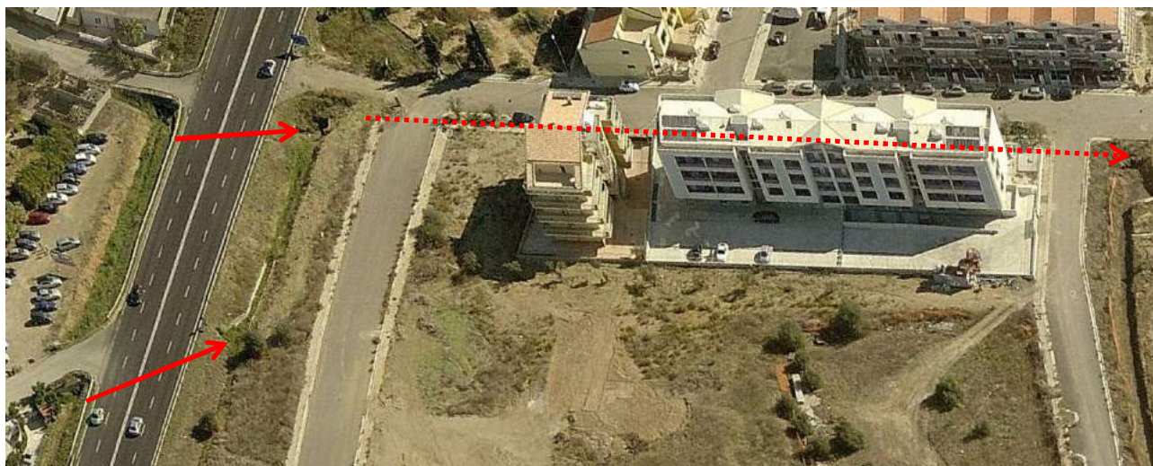
Figura 39 Veduta aerea delle linee di scorrimento delle acque del tronco B nelle aree contermini della SS 130
