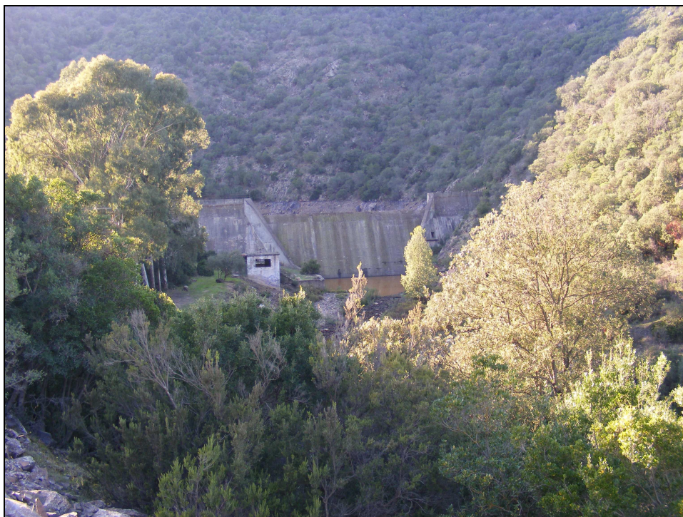
Figura 18: Diga sul Rio di Santa Lucia – Località Is Crabiolus
