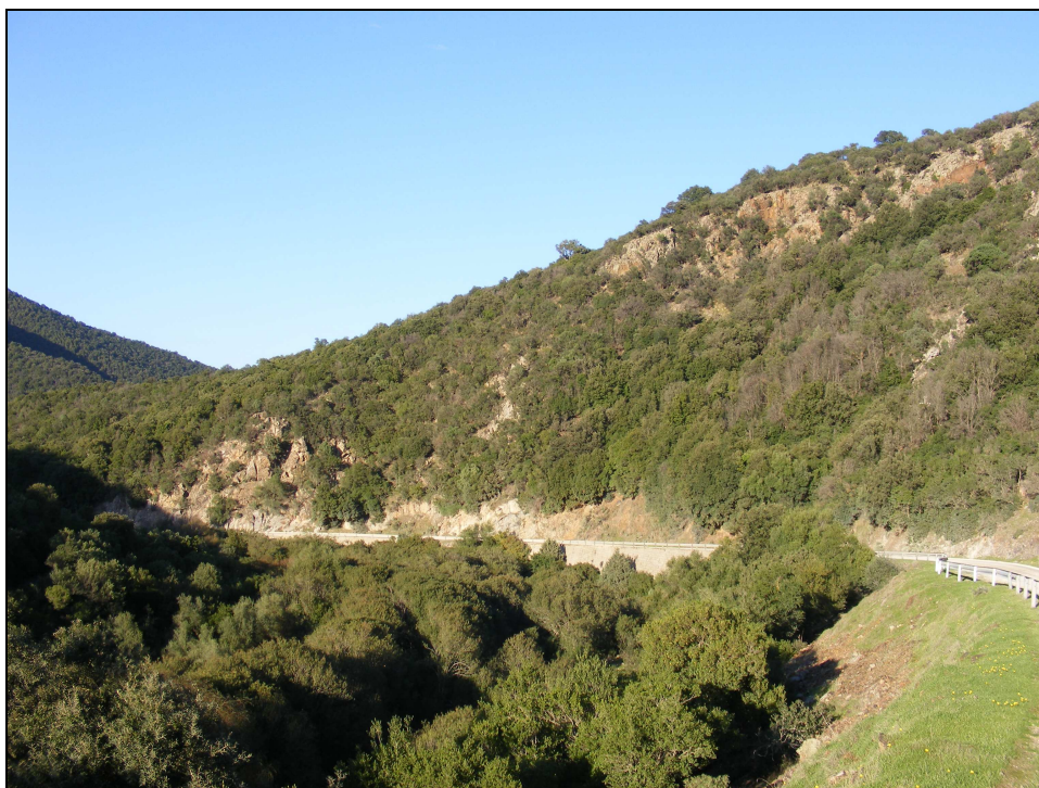
Figura 19: Versante roccioso e strada provinciale n°1 – Località Serra Acqua Stanziali
