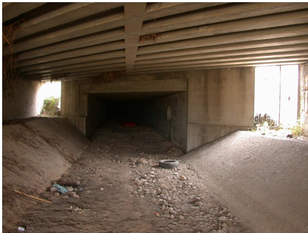
Figura 10 Nuxedda valle – imbocco del tratto tombato sotto la SS 130
