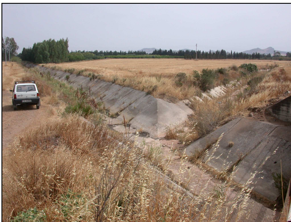
Figura 2 Confluenza tra Canale F monte (a sinistra) e rio San Gemiliano
