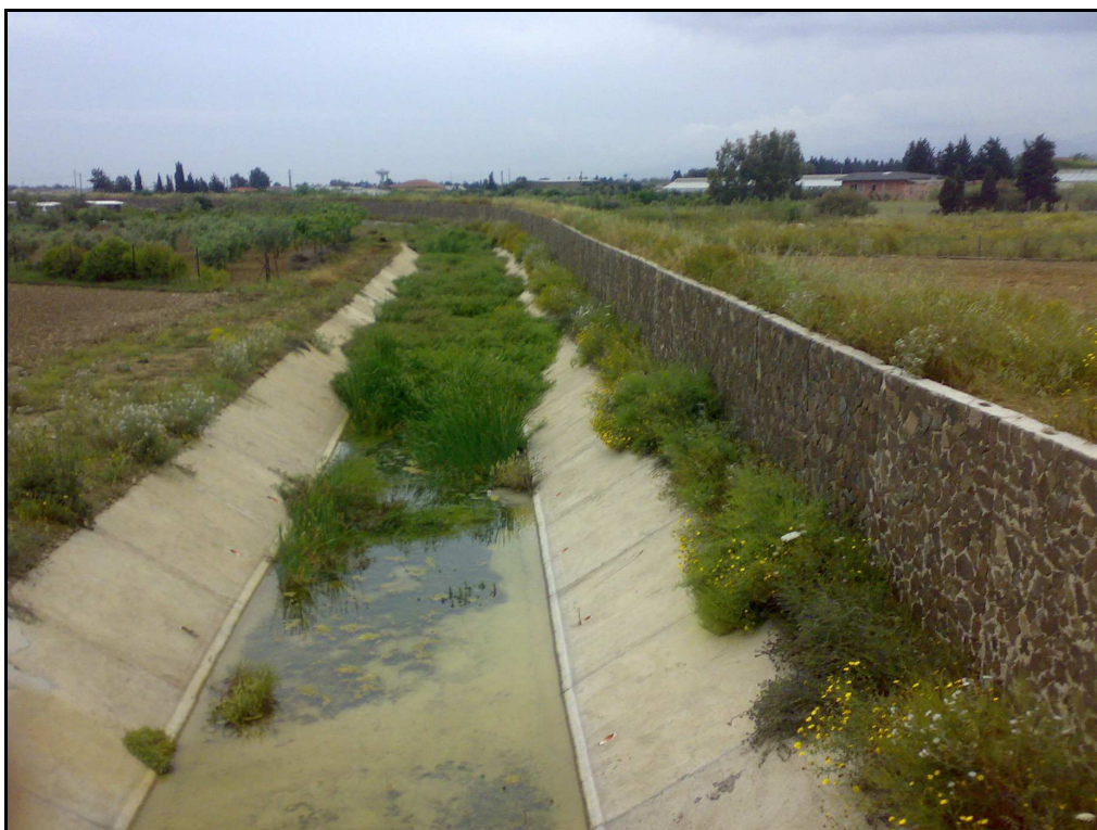
Figura 5 Rio Nuxedda principale – tratto arginato in sponda destra
