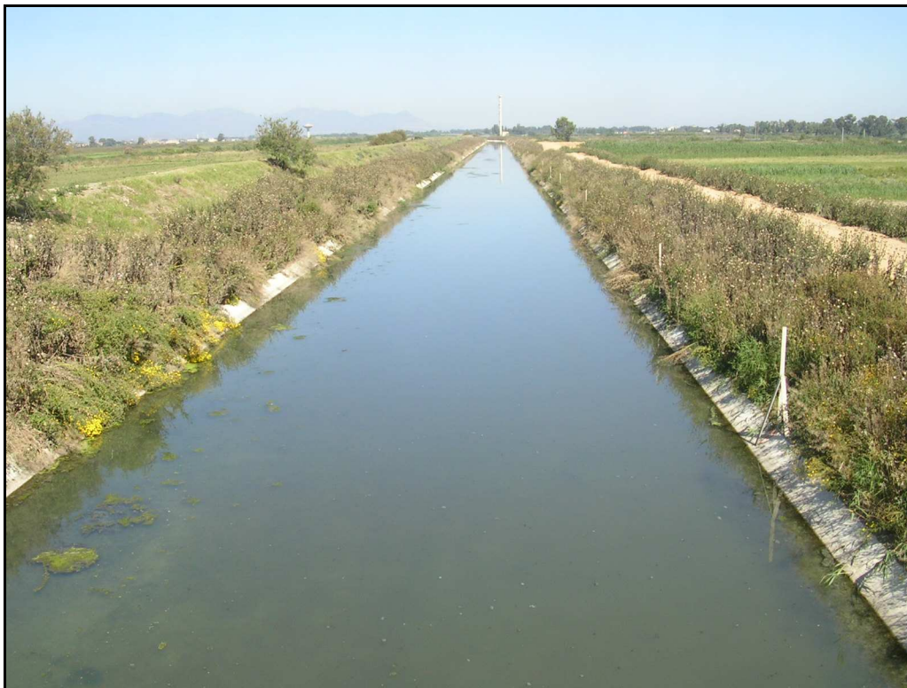
Figura 12 Canale A – colatore sinistro del Fluminimannu
