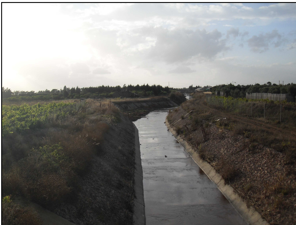
Figura 7 Scolmatore (sullo sfondo a dx il canale F medio sud e a sx l'imbocco di F valle)
