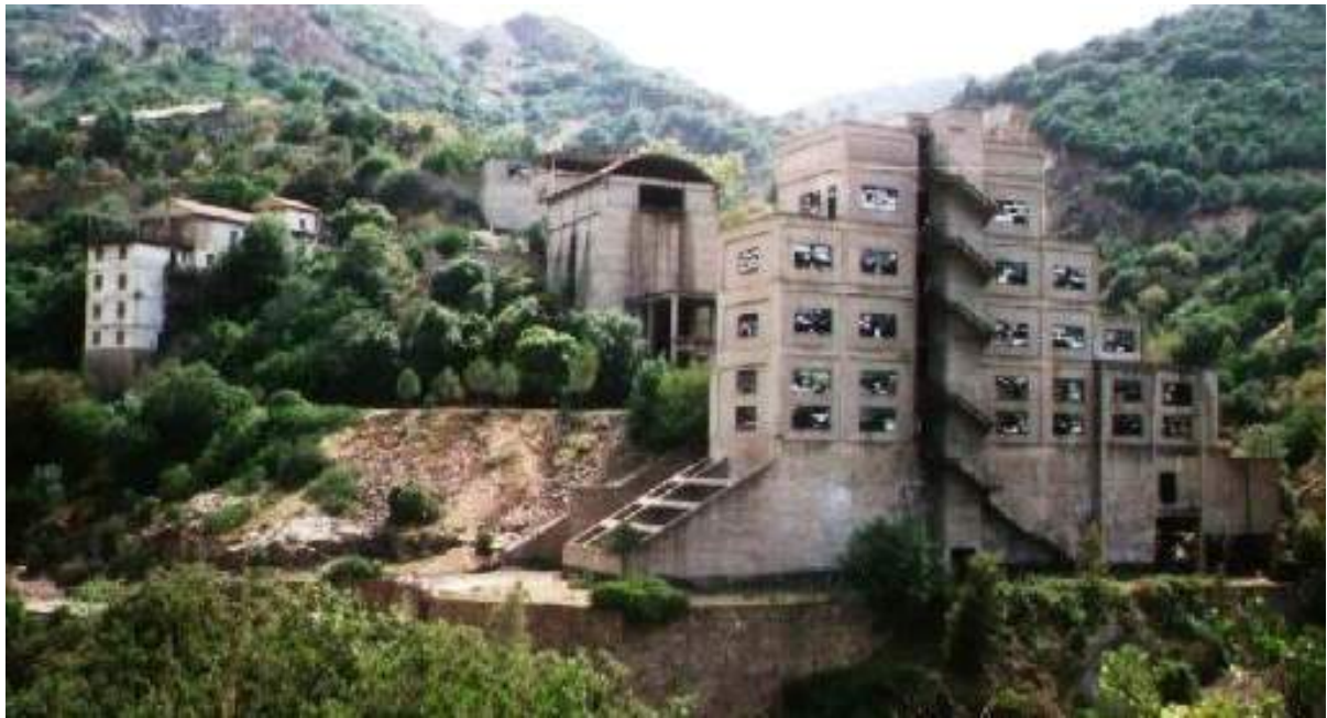
Fig. n. 6 – Area mineraria di San Leone
