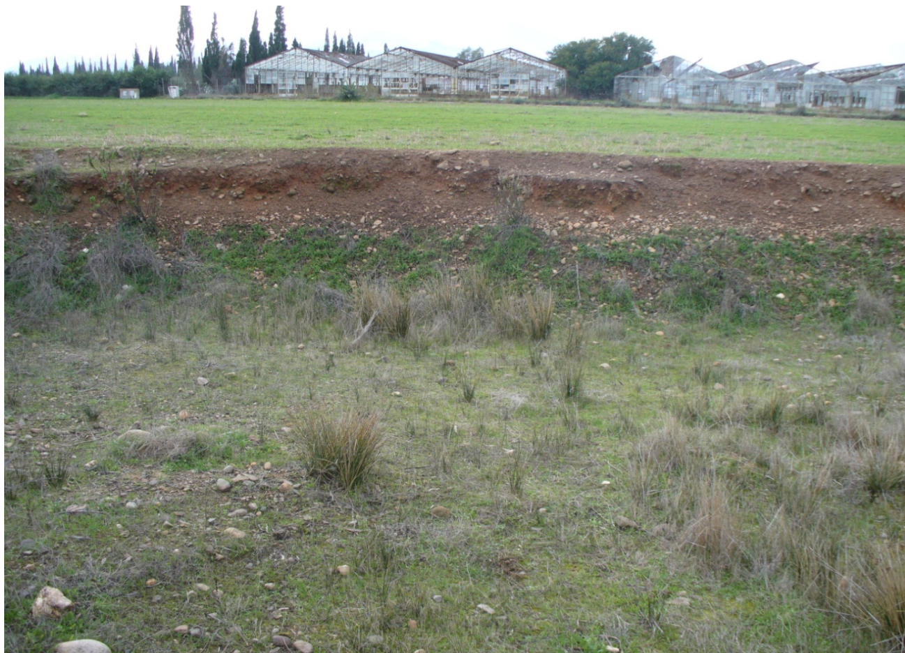
Foto - Scarpata erosiva di natura antropica
