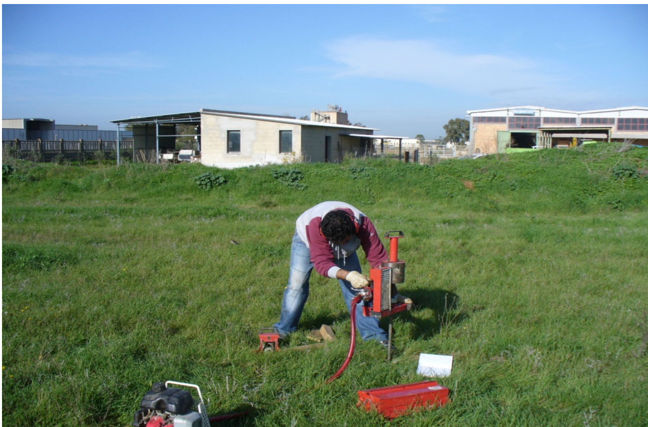
Foto - Esecuzione prova penetrometrica
