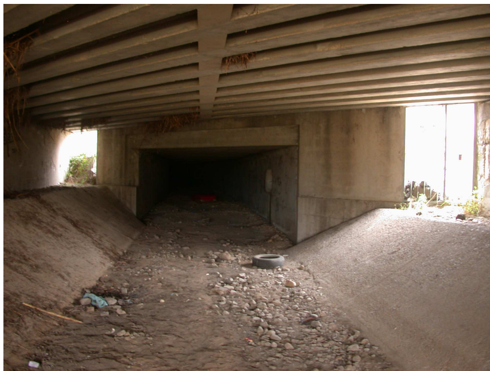
Figura 13 Nuxedda valle – imbocco del tratto tombato sotto la SS 130
