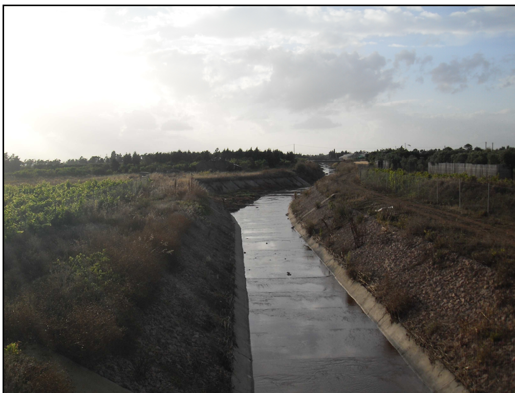
Figura 10 Scolmatore (sullo sfondo a dx il canale F medio sud e a sx l'imbocco di F valle)
