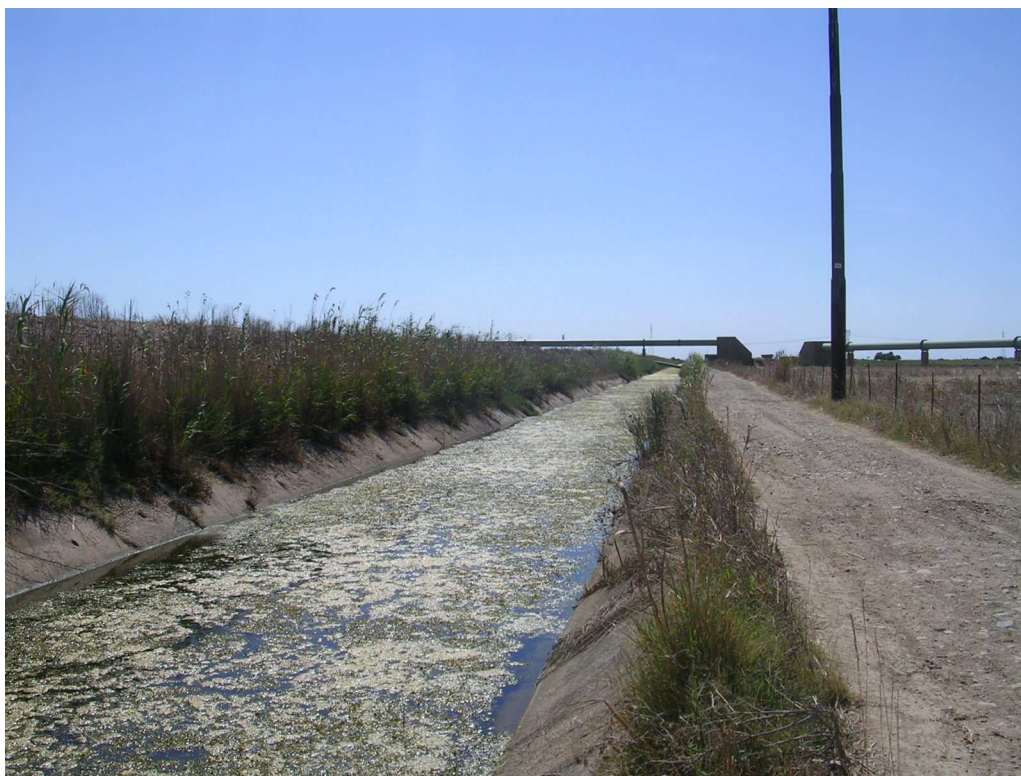
Figura 17 Canale Colatore Dx Cixerri
