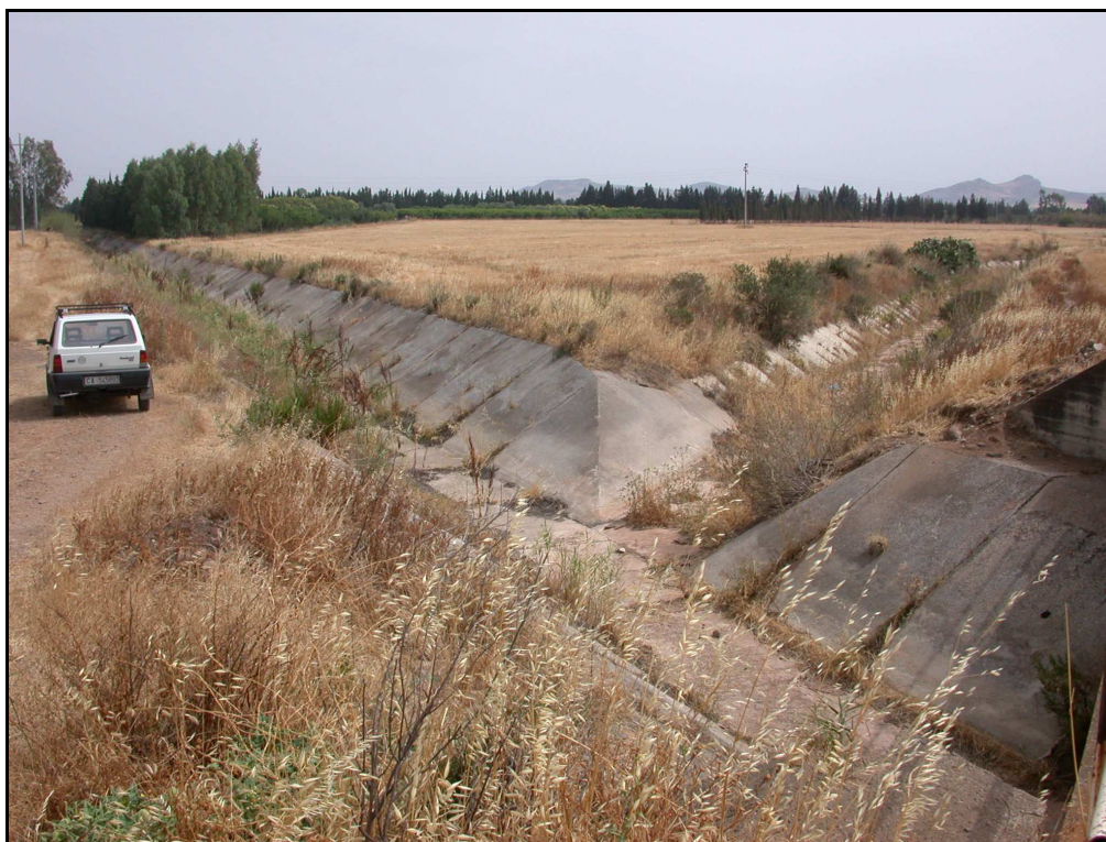
Figura 5 Confluenza tra Canale F monte (a sinistra) e rio San Gemiliano
