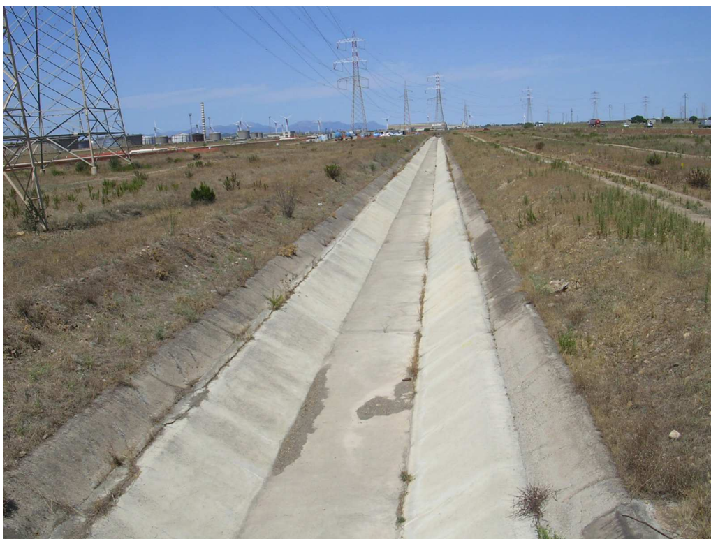
Figura 18 Canale di bonifica parallelo alla strada consortile 195 - 130
