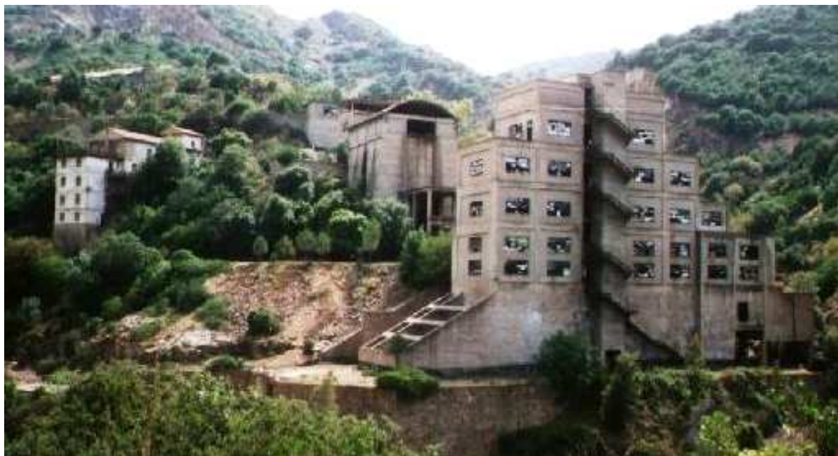
Fig. n. 6 – Area mineraria di San Leone
