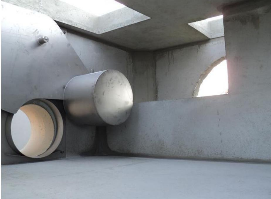
Fig. 27 – Pozzetto con sistema di regolazione portata
